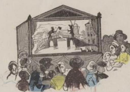
De gebroken brug.
